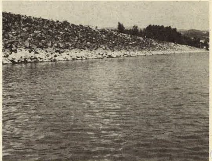
Dieselbe Uferstelle, jedoch im heutigen Zustand. Begrabtes Ufer, eine sterile Steinwüste. Technisch perfekt, aber, ohne ökologische Funktion. Dieser Zustand besteht seit 1972 ohne jegliches Anzeichen von Grün. Das heißt: Die geschlagenen Wunden verheilen nicht. Ist das umweltfreundliche Wasserkraft?
